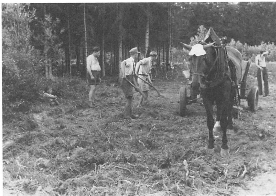
Unersetzliche Helfer bei den Rodungsarbeiten waren besonders die Pferde
