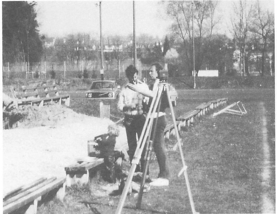
Abteilungsleiter Franz Neumaier bei Vermessungsarbeiten für die Tennisplätze
