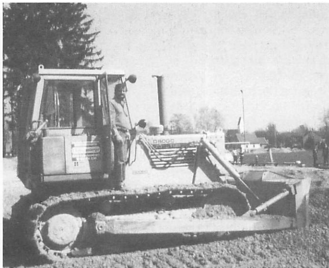
Eine Menge Planierarbeiten waren nötig, bis unsere schönen Tennisplätze angelegt werden konnten.
