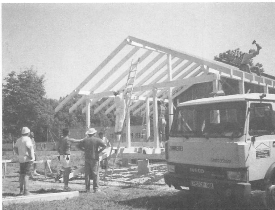
Das Balkengerüst ist fast fertiggestellt
