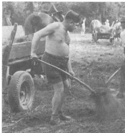
Schwerste Arbeit war bei der Rodung für das neue Fußballfeld zu verrichten
