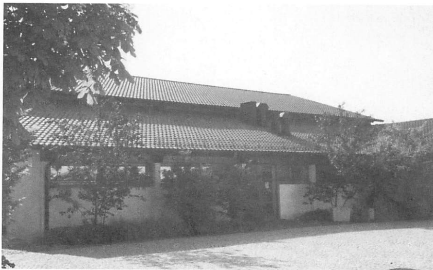
Unsere schöne Gemeindehalle, die 1991 fertiggestellt wurde
